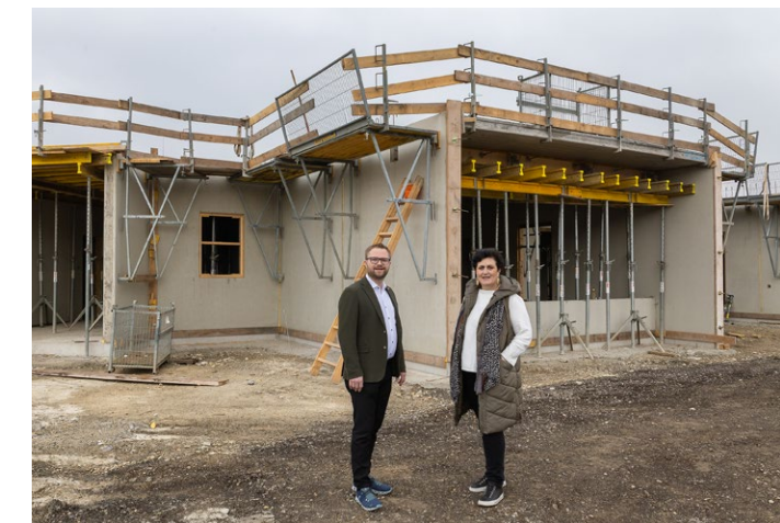
Die zuständige Stadträtin Dora Polke und Bürgermeister Erich Stubenvoll überzeugen sich vom planmäßigen Fortschritt der Arbeiten am neuen Kindergarten Zaya-Mühlbach.
