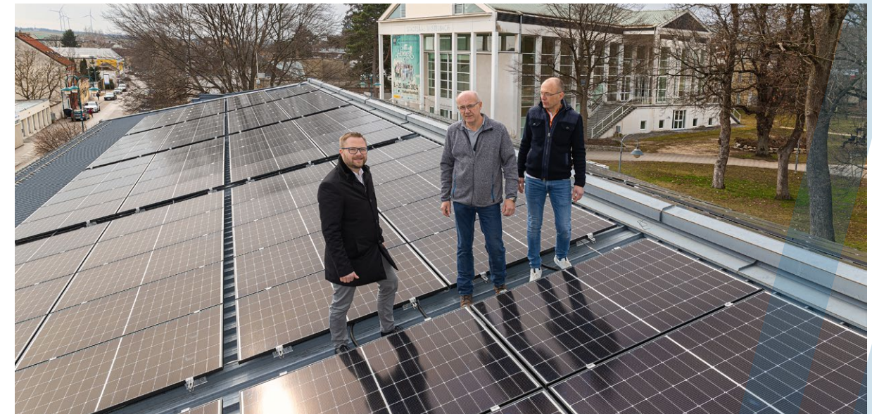
Besichtigung der fertiggestellten 75 kWp-Photovoltaikanlage am FF-Dach durch Bürgermeister Erich Stubenvoll, Kommandant-Stellvertreter Günter Bader und Elektrotechniker Udo Nawrata (Elektrotechnik Kraus)
