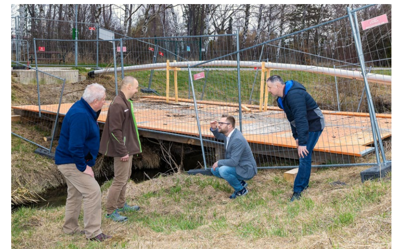
Ortsvorsteher Erich Stubenvoll sen., Bürgermeister Erich Stubenvoll und Gemeinderat Wolfgang Inhauser lassen sich von Holzbau-Meister Reinhard Lechner den neuen Brücken-Aufbau erklären. Derzeit sieht man nur das für die Arbeiten nötige Provisorium, die neue Brücke wird im Moment in der Halle der Firma Holzbau Lechner zusammengebaut.
